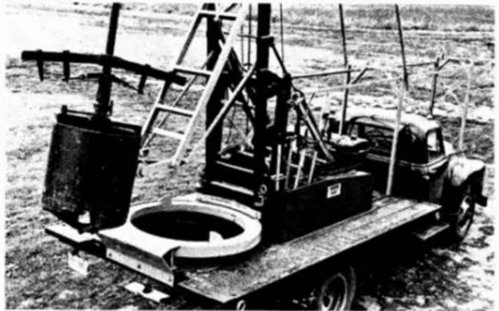
วิธีการเจาะด้วยสว่านแบบ Bucket auger (จาก Johnson Division, 1975)
