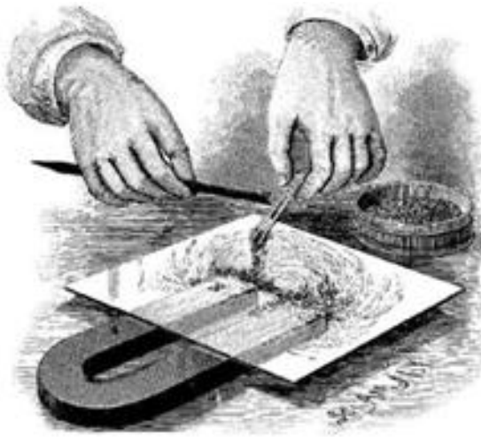
รูปแสดงการทดลองโรยผงเหล็กเพื่อดูสนามแม่เหล็ก
