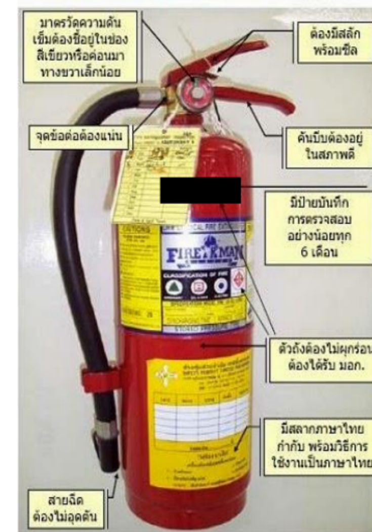
สภาพถังดับเพลิงไม่สึกกร่อน ข้อต่อแน่นหนา สายฉีดไม่แตกหัก
