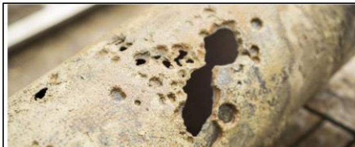
ภาพที่ 7.2 การกัดกร่อนแบบรูเข็ม (Pitting Corrosion)
